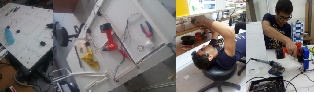
Elektrik tesisatının çekilmesi
